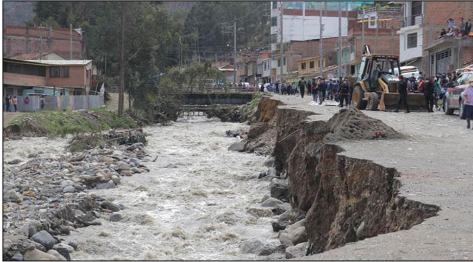
Figura 18. Desborde del río Quillcay en el distrito de independencia
