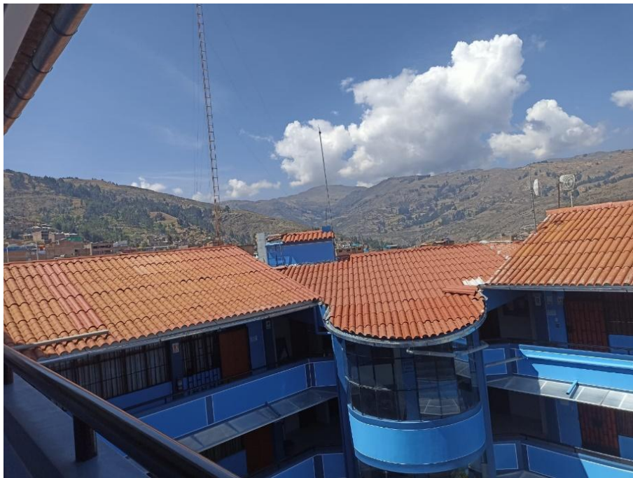
Fotografía N°15: Se puede observar la vista del cuarto nivel.
