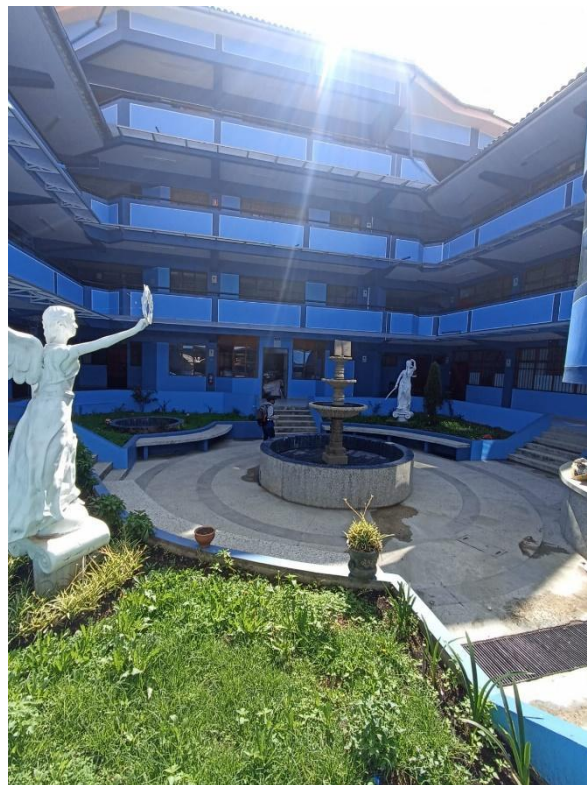
Fotografía N° 3: Pileta y el patio central de la Facultad de Derecho y Ciencias Políticas.
